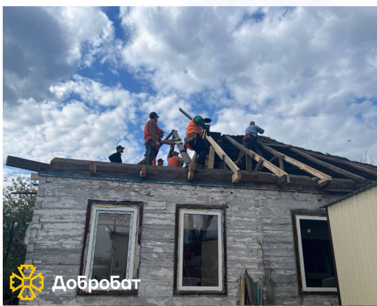
Робота волонтерів з ремонту даху в Гостомелі
