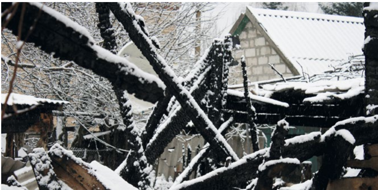
Разрушенный во время обстрела жилой дом, Донецкая область. Фото: DRA, все права защищены
